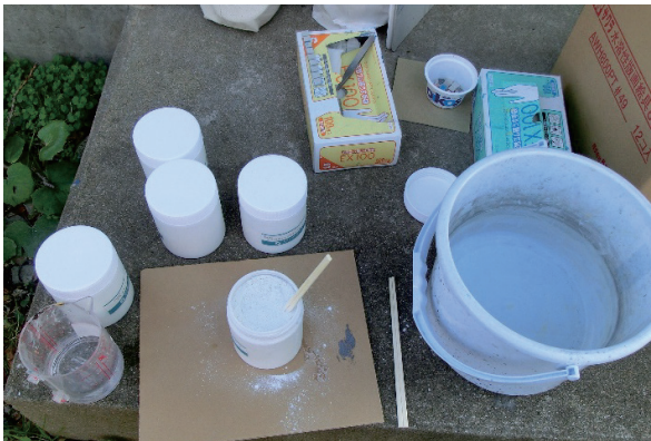
図24 目地セメントを水で練る様子
