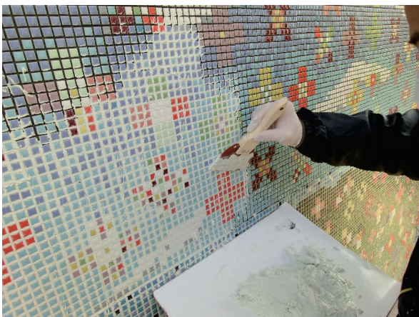
図 33 ゴムベラを使って目地セメントを塗布する様子
