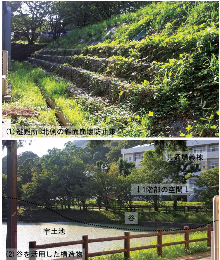
写真3 避難所 B の上流側の景観
