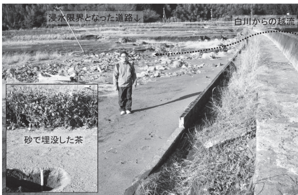
写真3 外牧地区の被害状況
