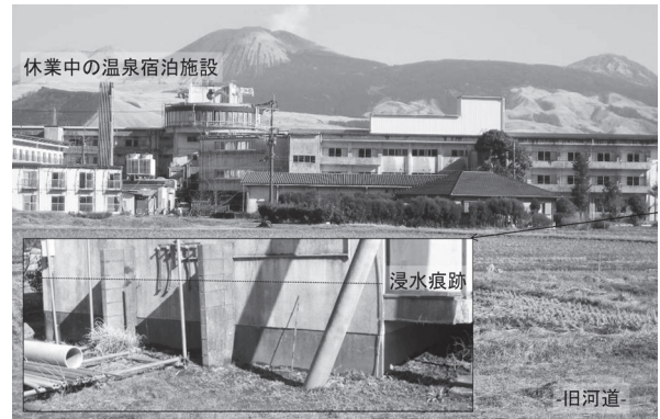
写真2 無田地区の被害状況
