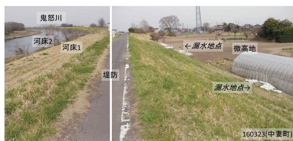
写真11 写真10の天端から見た堤内外の景観
